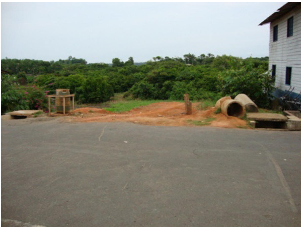
ILUSTRAÇÃO 4.1.2.2 – BOCAS DE LOBO NO PERÍMETRO URBANO DE ALVARÃES/AM.
