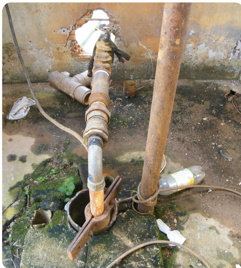
ILUSTRAÇÃO 4.1.2.1 – CONDIÇÕES DOS POÇOS DE CAPTAÇÃO DE ÁGUA DE AMATURÁ
