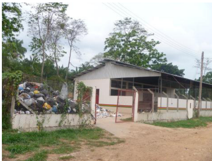
ILUSTRAÇÃO 4.2.4.6 – ÁREA PROVISÓRIA DE DESCARTE DE RESÍDUOS PRÓXIMA AO GALPÃO DO INCINERADOR
