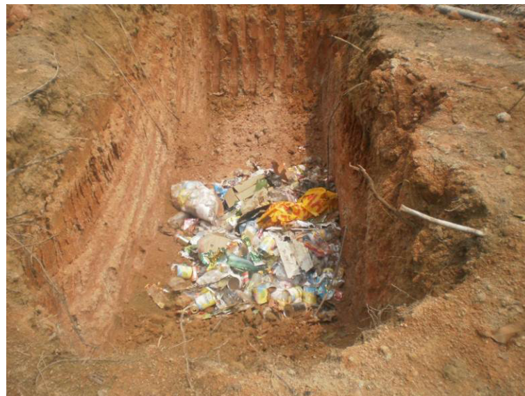
ILUSTRAÇÃO 4.2.4.12 - VALA FEITA PARA DEPOSITAR OS RESÍDUOS E DEPOIS ENTERRA-LO EM ANAMÃ. FOTO: JACKELINE OLIVEIRA.
