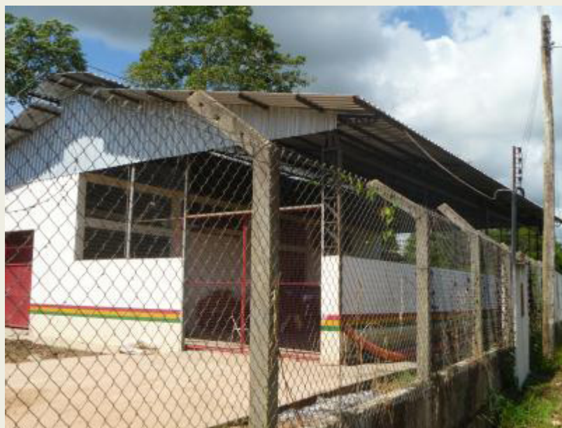
ILUSTRAÇÃO 4.2.4 3 – GALPÃO DO INCINERADOR
