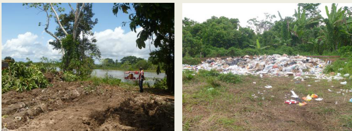
ILUSTRAÇÃO 4.2.4.5 – ÁREA PROVISÓRIA DE DESCARTE DE RESÍDUOS PRÓXIMO AO PARANÁ DO ANAMÃ
