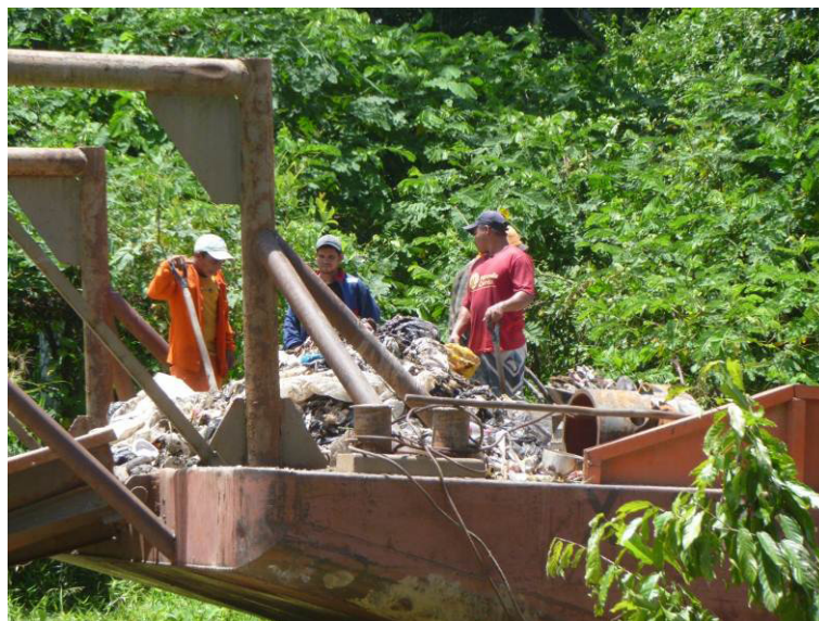
ILUSTRAÇÃO 4.2.3.5 - Balsa utilizada no transbordo dos resíduos.
