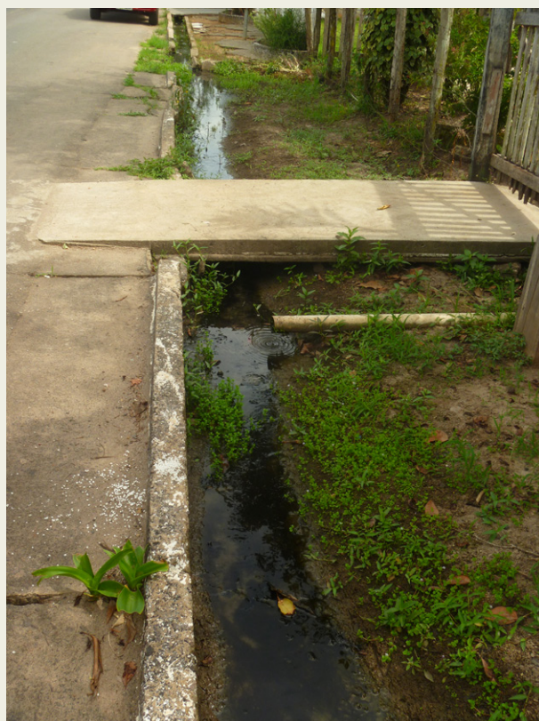
ILUSTRAÇÃO 4.1.2.1 – ESGOTO SENDO EM VIAS PÚBLICAS
