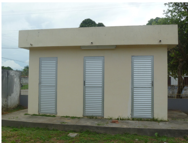
ILUSTRAÇÃO 4.2.3.5 - LOCAL DE ESTOCAGEM DE RSS NO HOSPITAL MUNICIPAL – BARCELOS
