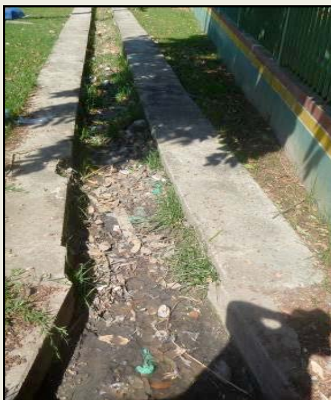
ILUSTRAÇÃO 4.1.2.3. – VALA DE DRENAGEM NO CENTRO DO PERÍMETRO URBANO EM BARRERINHA/AM.
