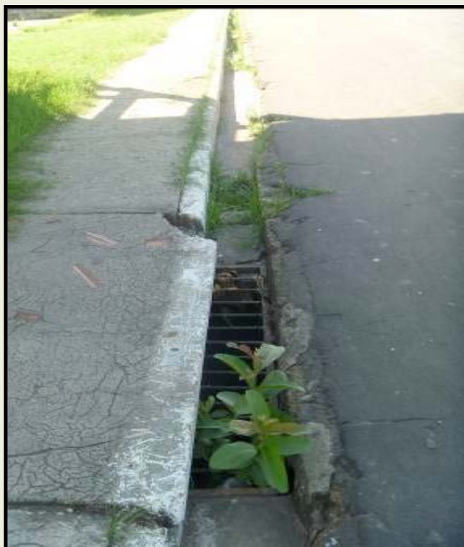
ILUSTRAÇÃO 4.1.2.2. – BOCA DE LOBO TIPO GRELHA EM BARRERINHA/AM.
