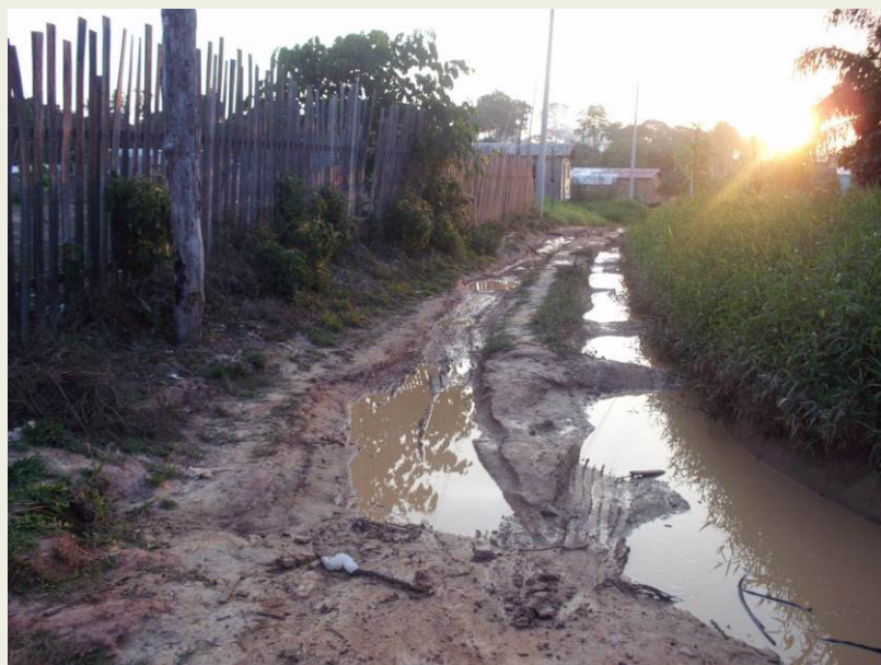
ILUSTRAÇÃO 4.1.2.2 - ESTRADA DE ACESSO AO LIXÃO – BERURI/AM.
