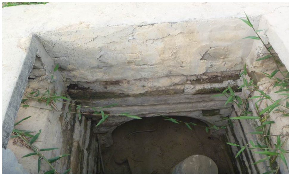
ILUSTRAÇÃO 4.1.2.3 – TUBULAÇÃO DE ÁGUAS PLUVIAIS (BOCA-DE-LOBO)
