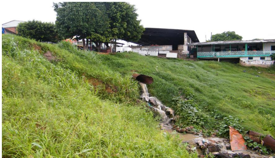
ILUSTRAÇÃO 4.1.2.2 ESTADO DAS TUBULAÇÕES DAS ÁGUAS PLUVIAIS.
