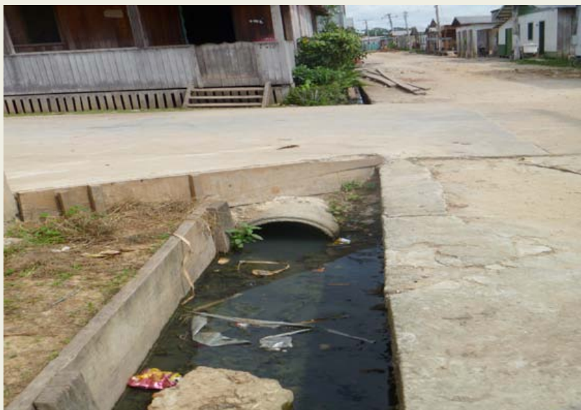
ILUSTRAÇÃO 2.7.1 – REDE DE DRENAGEM E ESGOTO EM CANUTAMA/AM.
