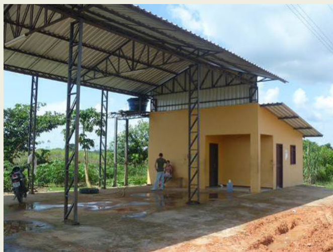
ILUSTRAÇÃO 4.1.2.3 – INSTALAÇÃO DE APOIO. FOTO: PLAMSAN.
