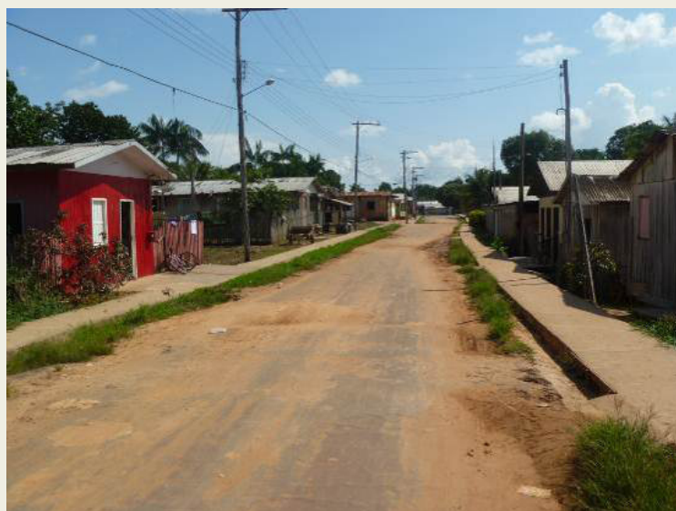
ILUSTRAÇÃO 2.6.2 – RUA COM AUSÊNCIA DE MANUTENÇÃO
