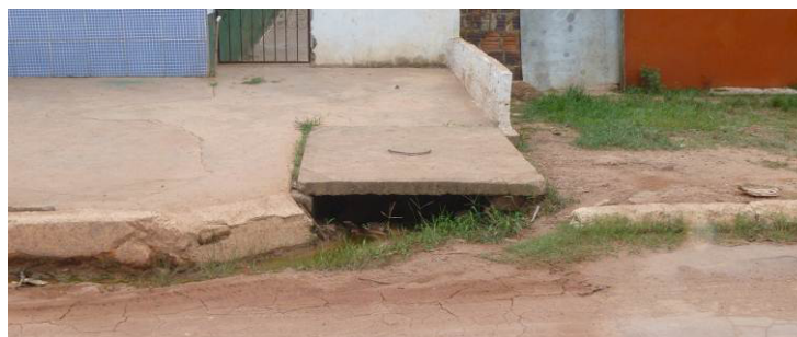
ILUSTRAÇÃO 4.1.2.6: DEMONSTRAÇÃO DE BOCA-DE-LOBO EM CAREIRO/AM.
