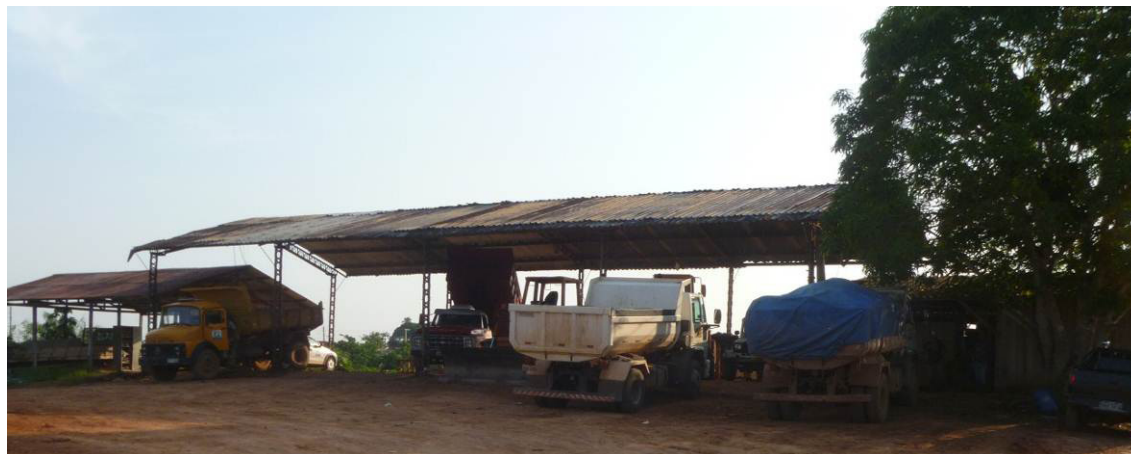
ILUSTRAÇÃO 4.2.3.2 - GARAGEM CENTRAL DOS VEÍCULOS DA PREFEITURA DE CAREIRO/AM. FOTO: PLAMSAN.
