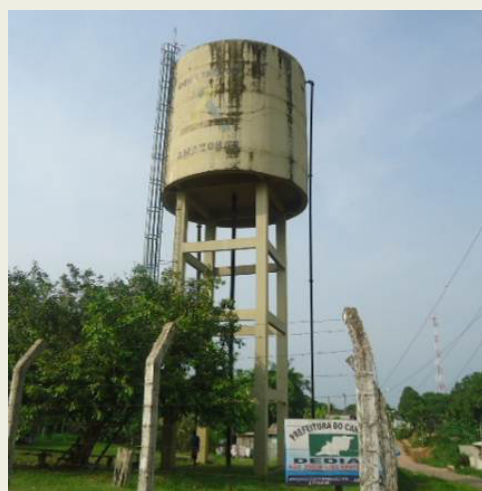
ILUSTRAÇÃO 4.1.2.2: RESERVATÓRIO ELEVADO NA SEDE DO CAREIRO.
