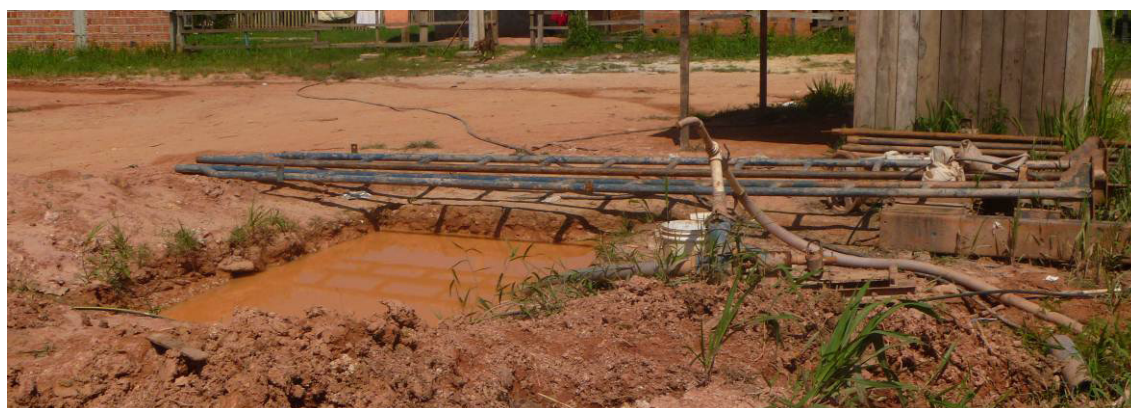
ILUSTRAÇÃO 4.1.2.3: POÇO PERFURADO NA PERIFERIA DE COARI, AINDA SEM FUNCIONAMENTO.
