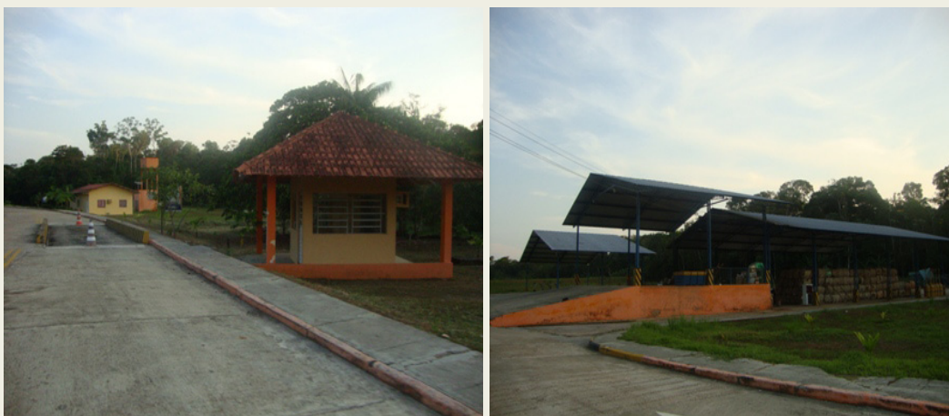
ILUSTRAÇÃO 4.2.4.1: À ESQUERDA A BALANÇA DO ATERRO DE COARI E A DIREITA O GALPÃO DE TRIAGEM.
