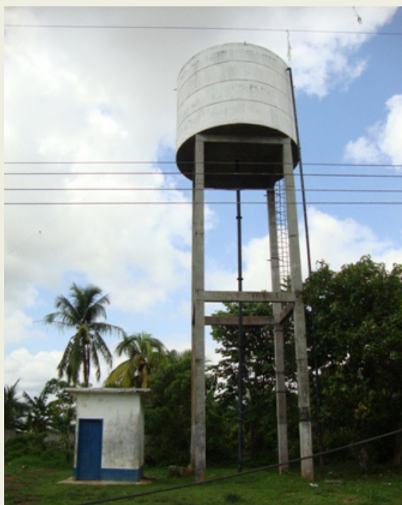
ILUSTRAÇÃO 4.1.2.1: CASA DE POÇO E RESERVATÓRIO EM CODAJÁS.
