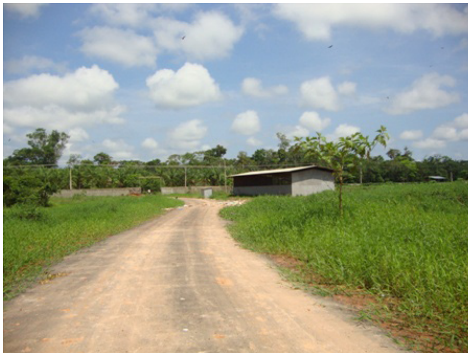
ILUSTRAÇÃO 4.2.4.2: ENTRADA AO LOCAL DE DEPOSIÇÃO DE RESÍDUOS.
