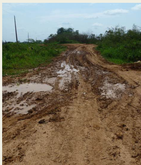
ILUSTRAÇÃO 4.2.4.1: VIA DE ACESSO AO LIXÃO.
