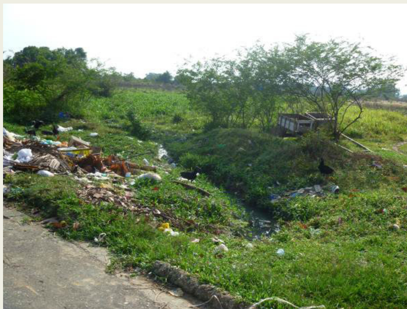
ILUSTRAÇÃO: 4.2.3.3: ACÚMULO DE LIXO EM ÁREA INAPROPRIADA.
