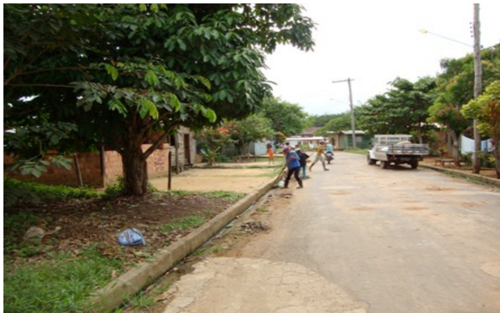
ILUSTRAÇÃO: 4.1.2 VIA NO MUNICÍPIO — FALTA DA DRENAGEM.
