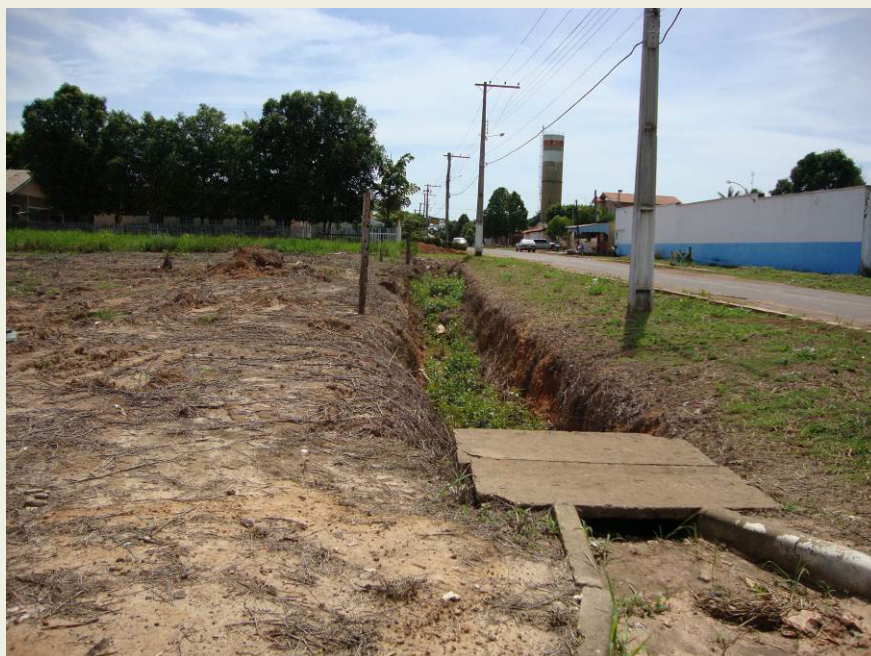
ILUSTRAÇÃO 4.1.2.2: DRENAGEM DE ÁGUAS PLUVIAIS EM HUMAITÁ - AM.
