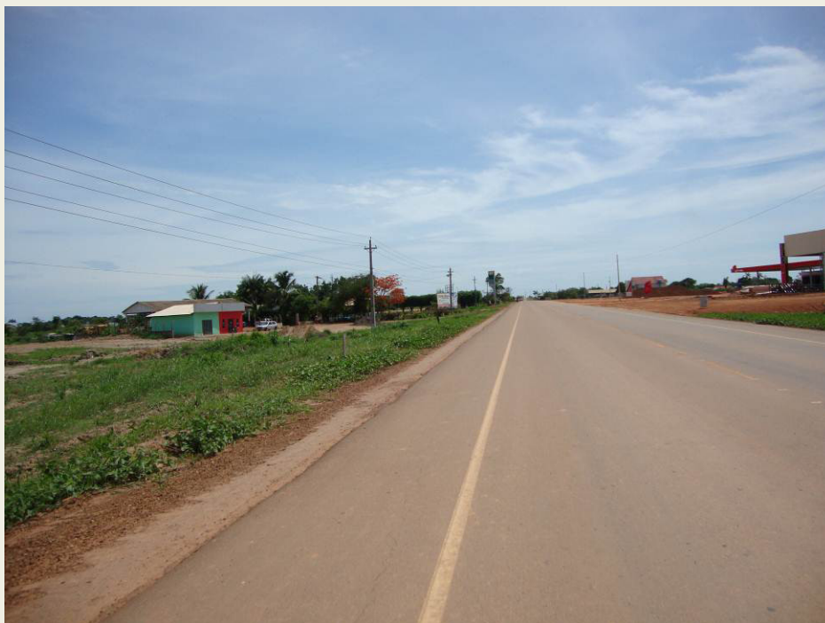
ILUSTRAÇÃO 2.6: RUAS LARGAS E ASFALTADAS, PORÉM SEM SARJETAS. FONTE PLAMSAN
