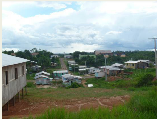
ILUSTRAÇÃO 2.6.2 – CASAS CONSTRUÍDAS EM MADEIRA
