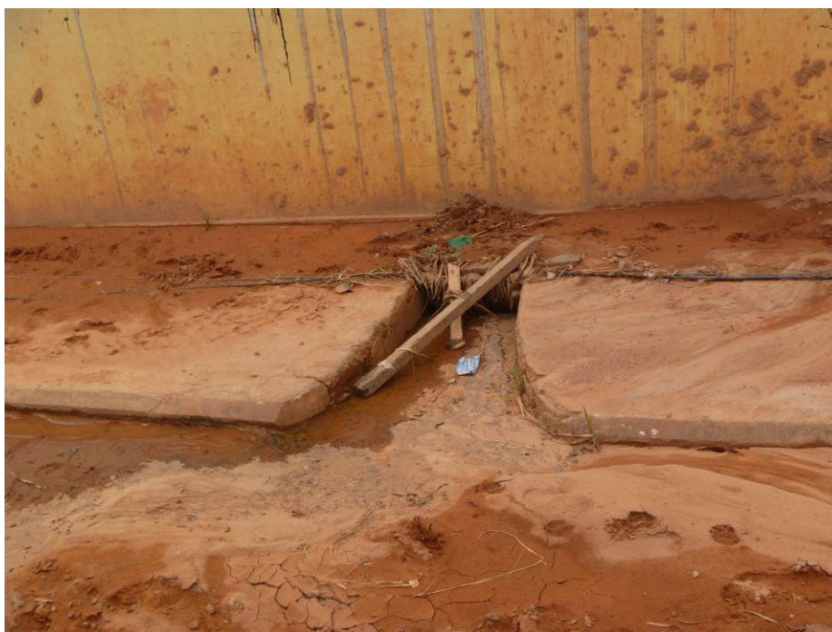
ILUSTRAÇÃO 4.1.2.2 – BOCA DE LOBO NO PERÍMETRO URBANO DE IPIXUNA/AM. FOTO: PLAMSAN.
