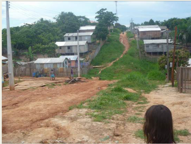
ILUSTRAÇÃO 2.6.1 – RUA SEM PAVIMENTAÇÃO
