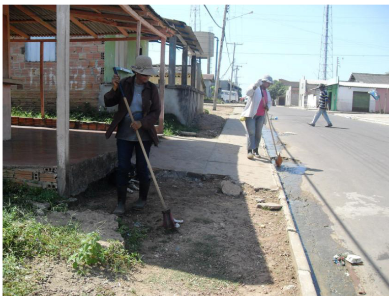
ILUSTRAÇÃO 4.2.3.2 – TRABALHADORES COM EPIs INCOMPLETOS. (FONTE: TCE/AM)
