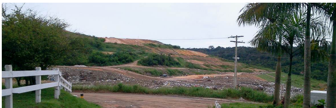
ILUSTRAÇÃO 4.1.3.2: RESÍDUOS COBERTOS NO ATERRO SANITÁRIO DE MANAUS.
