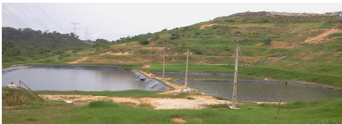
ILUSTRAÇÃO 4.1.3.3: LAGOAS DE TRATAMENTO NO ATERRO SANITÁRIO DE MANAUS.
