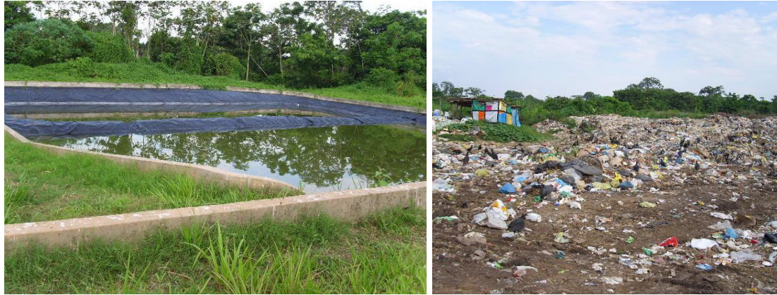
ILUSTRAÇÃO 4.2.4.3: LAGOAS DE TRATAMENTO DE CHORUME E VISTA PARCIAL DA ÁREA QUE RECEBEU RECURSO PARA IMPLANTAÇÃO DE UM ATERRO SANITÁRIO EM 2008. FONTE: TCE.
