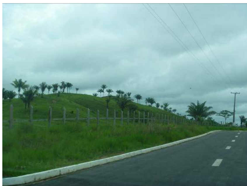
ILUSTRAÇÃO 2.6.2 – RUA PAVIMENTADA EM BOAS CONDIÇÕES
