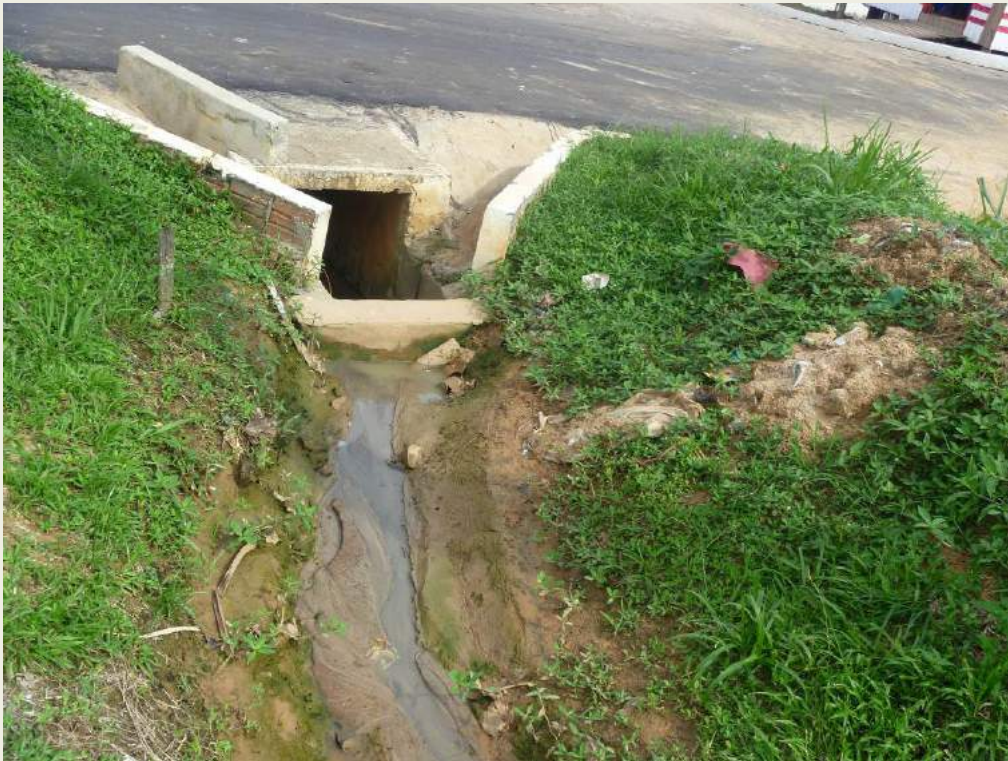
ILUSTRAÇÃO 4.1.2.2 – GALERIAS DE AGUAS PLUVIAIS NO PERÍMETRO URBANO DE ITAMARATI.
