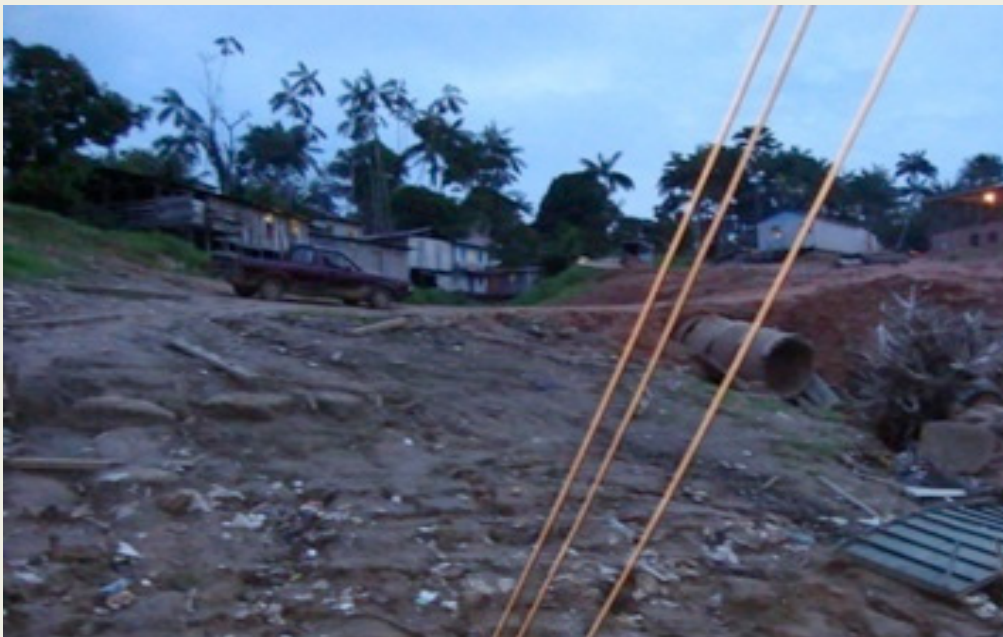
ILUSTRAÇÃO 4.1.2.3 – TUBULAÇÃO DE ÁGUAS PLUVIAIS.
