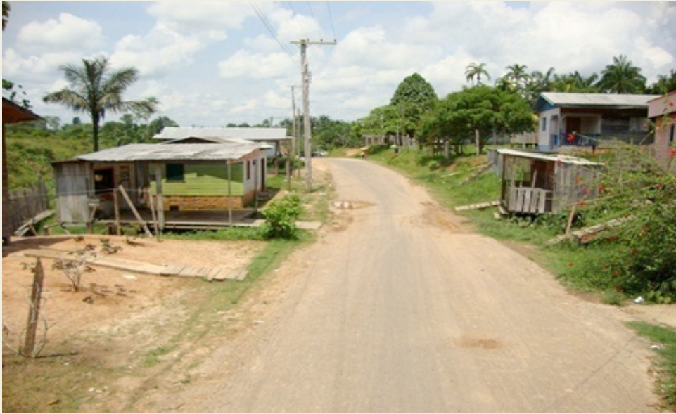
ILUSTRAÇÃO: 4.1.2.2 VIA NO MUNICÍPIO – FALTA DA DRENAGEM.
