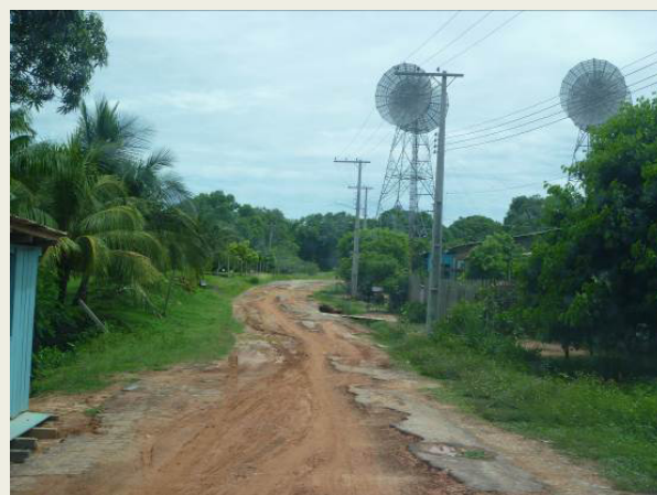
ILUSTRAÇÃO 2.6.4 – RUA SEM PAVIMENTAÇÃO
