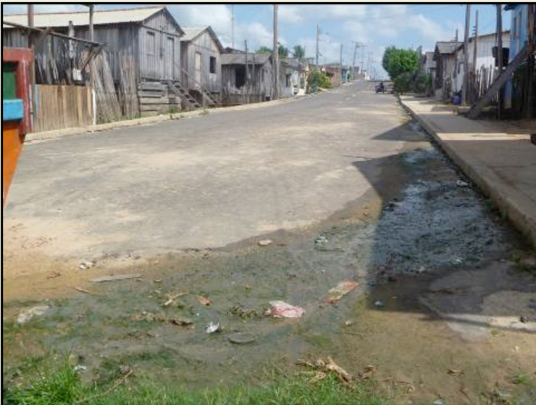
ILUSTRAÇÃO 2.7.2 – EFLUENTES DOMICILIARES EM VIA PUBLICA NO MUNICÍPIO DE NHAMUNDÁ/AM.
