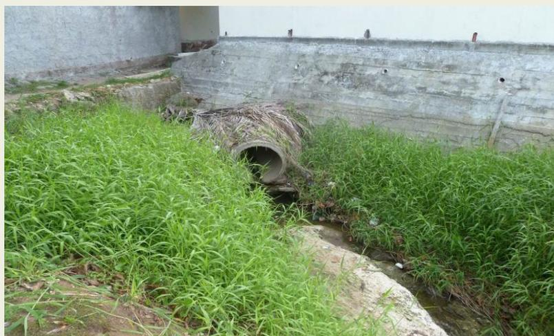
ILUSTRAÇÃO 4.1.2.2 – TUBULAÇÃO DE ÁGUAS PLUVIAIS DESEMBOLCANDO NUMA BOCA DE LOBO
