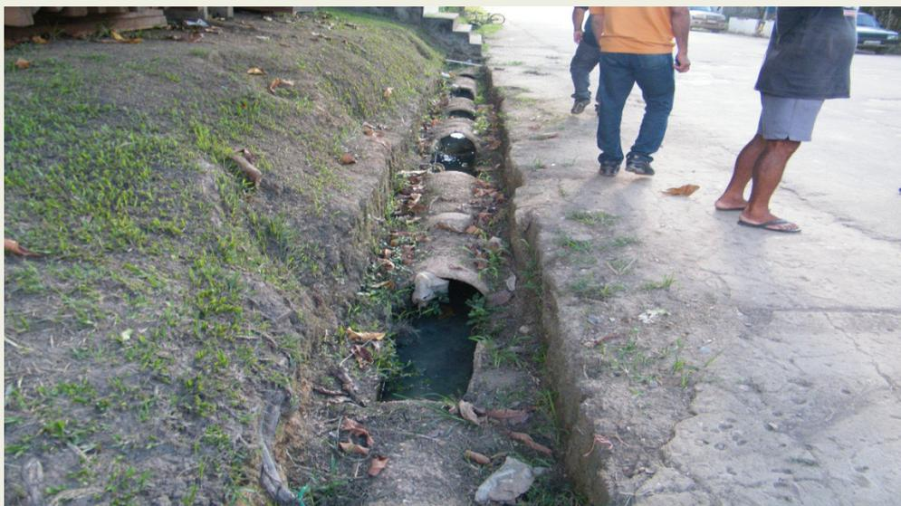
ILUSTRAÇÃO 4.1.2.2 – TUBULAÇÃO DE ÁGUAS PLUVIAIS DESEMBOCANDO NUMA BOCA DE LOBO
