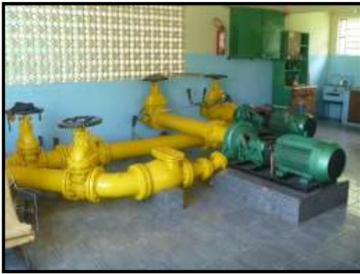
Ilustração 5.1.3.2 – Bomba na Estação Elevatória da Paraíba.
