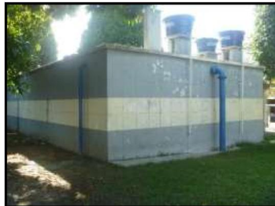
Ilustração 5.1.5.2 – RA em concreto armado com capacidade para 90.00 m<sup>3</sup> na estação Paraíba.
