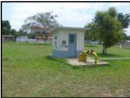
Ilustração 5.1.1.1 – Poço Tubular na Estação de Abastecimento da SHAM em Parintins/AM.
