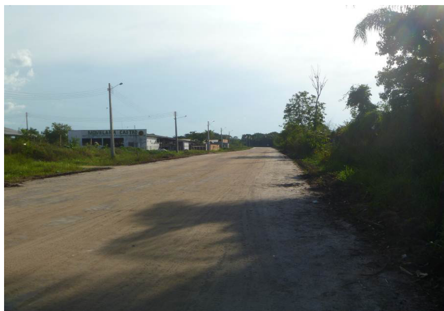
ILUSTRAÇÃO 4.2.4.2 – VISTA DE ACESSO AO LIXÃO EM PARINTINS/AM
