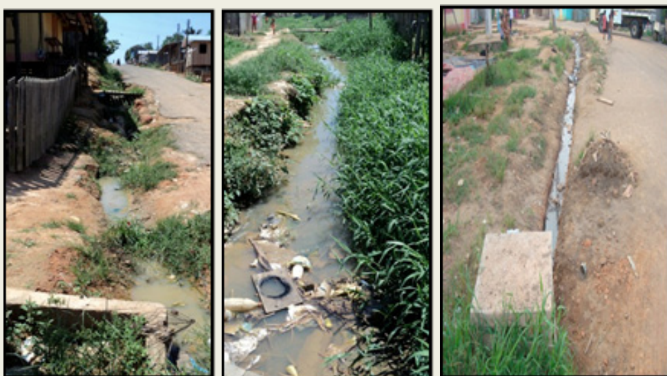
ILUSTRAÇÃO 4.1.2.6 – ESGOTOS A CÉU ABERTO PRÓXIMO A RESIDÊNCIAS
