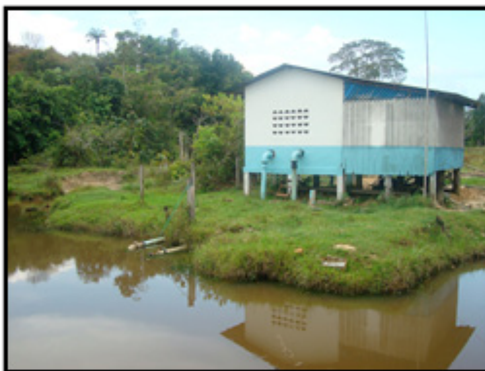
ILUSTRAÇÃO 4.1.2.1 - CASA DAS BOMBAS DE CAPTAÇÃO E O MANANCIAL IGARAPÉ PRETO (CACHOEIRA)
