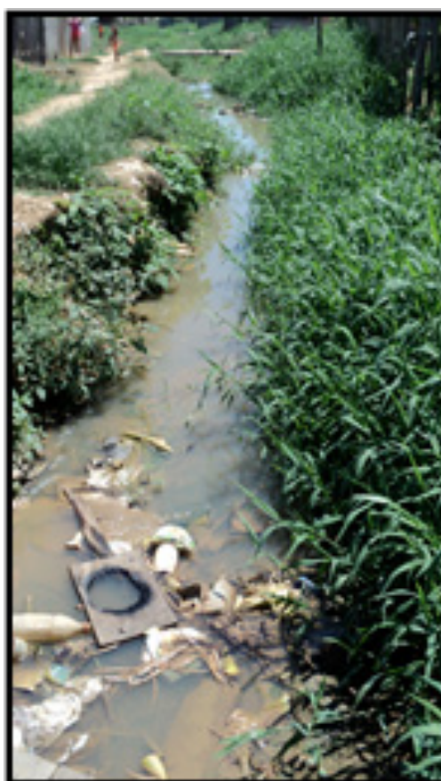
ILUSTRAÇÃO 2.7.2 – ESGOTO A CÉU ABERTO
