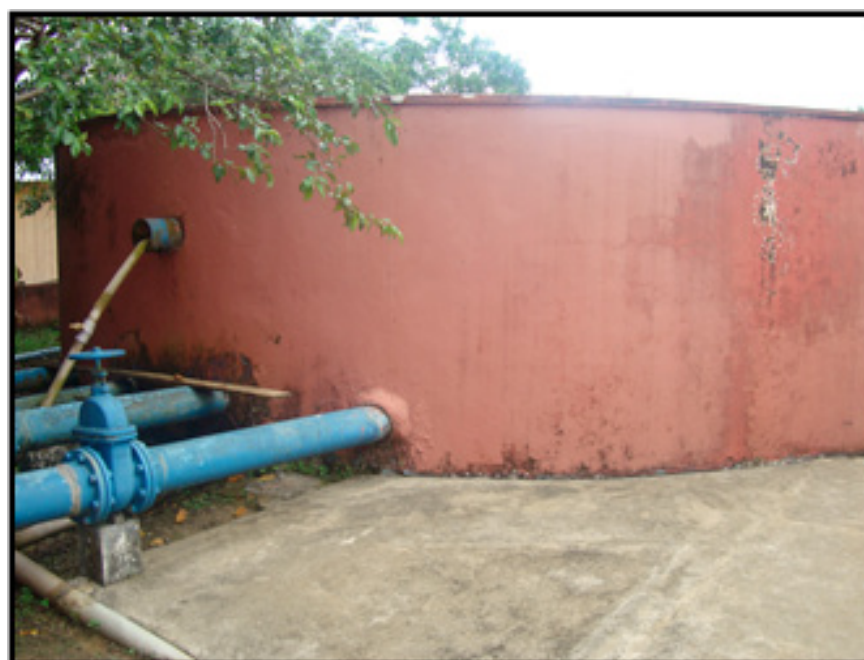
ILUSTRAÇÃO 4.1.2.4 – RESERVATÓRIO APOIADO
