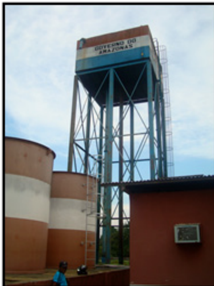
ILUSTRAÇÃO 4.1.2.3 – RESERVATÓRIO ELEVADO METÁLICO
