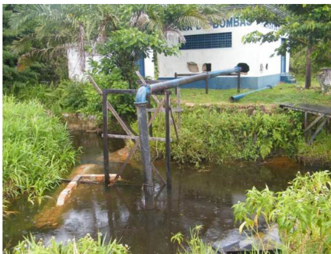
ILUSTRAÇÃO 4.1.2.1 – CAPTAÇÃO SUPERFICIAL
