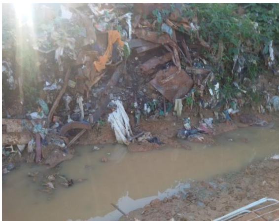
m) Acúmulo de água pluvial
