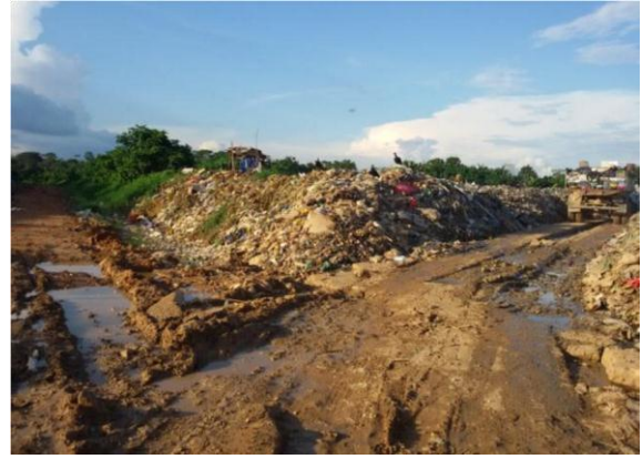
f) Via de trafegabilidade do Lixão
