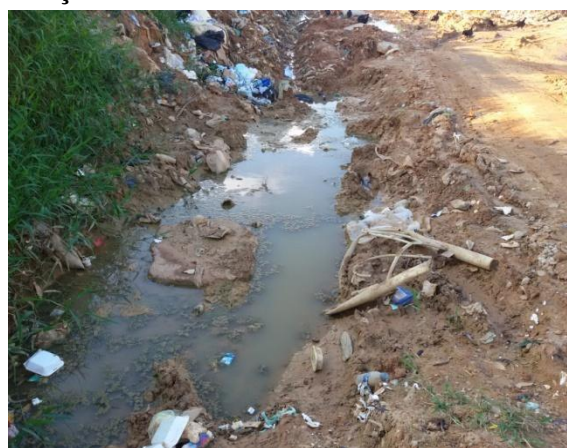
b) Acúmulo de água pluvial
