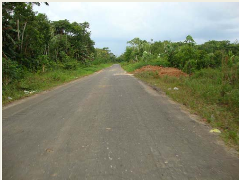
ILUSTRAÇÃO 4.2.4.2 – VISTA DE TRECHO DA ESTRADA UARINI-COPACÁ QUE DA ACESSO À ÁREA DO LIXÃO EM UARINI/AM. FOTO: PLAMSAN.
