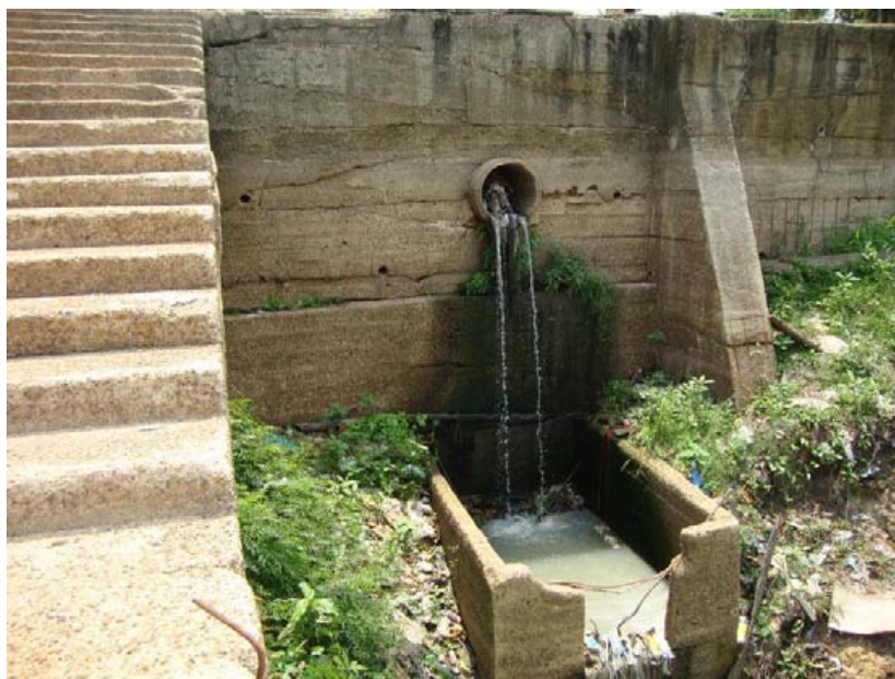
ILUSTRAÇÃO 4.1.2.2 - LANÇAMENTO DE AGUAS PLUVIAIS NO PERÍMETRO URBANO DE UARINI/AM. FOTO: PLAMSAN.
